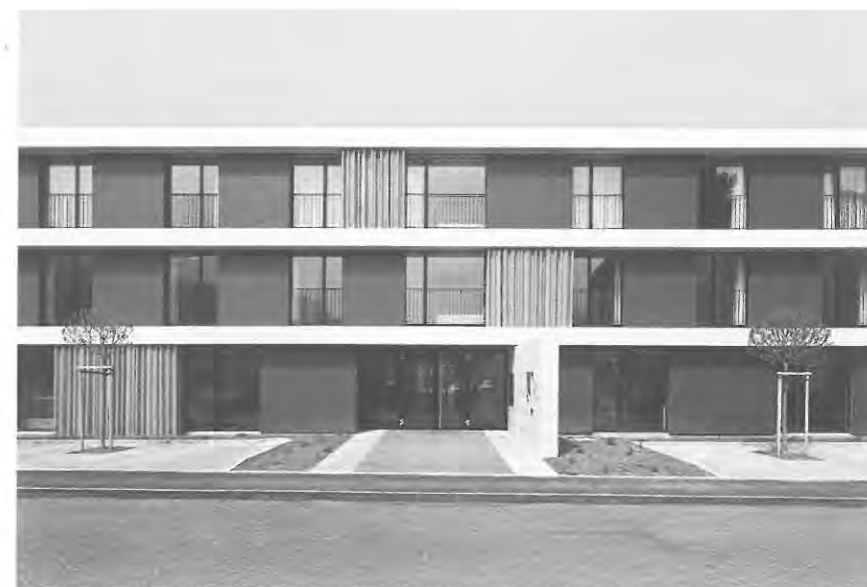
Blick auf den Haupteingang an der Längsfassade
