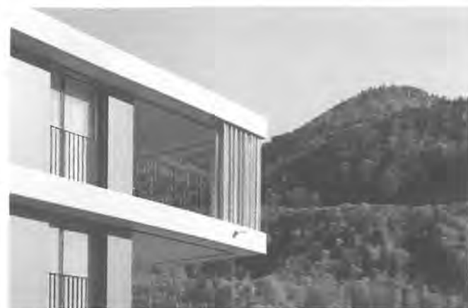
Gebäudedecke mit gewelltem Aluminium-Element
