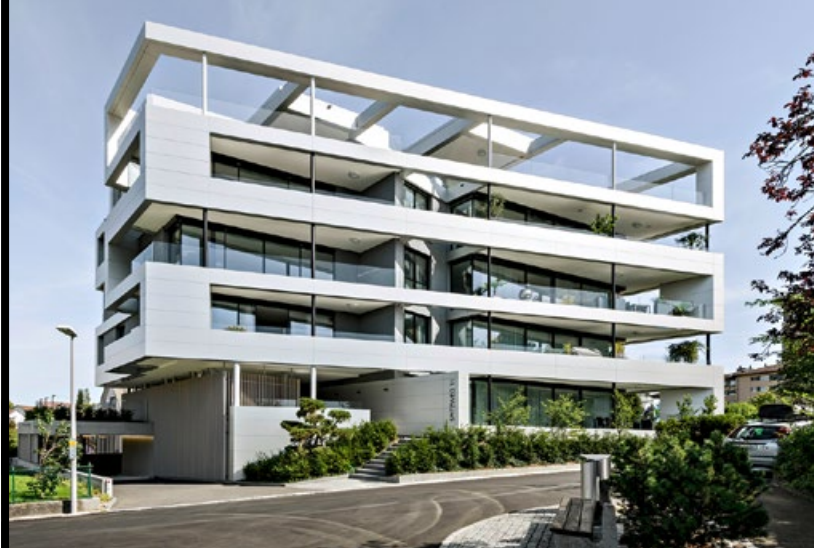
Im Obergeschoss wohnt der Bauherr. Die Aluminiumfassade ist eine Referenz an den Flughafen.
