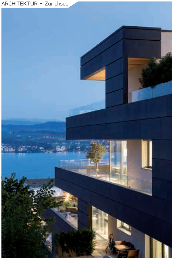
Terrassenförmig angelegt öffnen sich alle Wohneinheiten zum See hin. Leicht zurückversetzte Fensterfronten sorgen für Privatsphäre.
