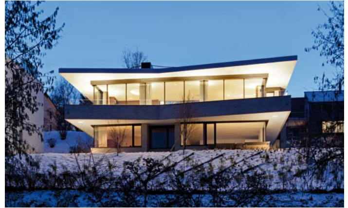
Die Beschränkung auf zwei Geschosse ermöglichte eine grosszügige Raumhöhe von 2,75 Metern. Die Inspiration der Case-Study-Häuser ist hier unverkennbar.
