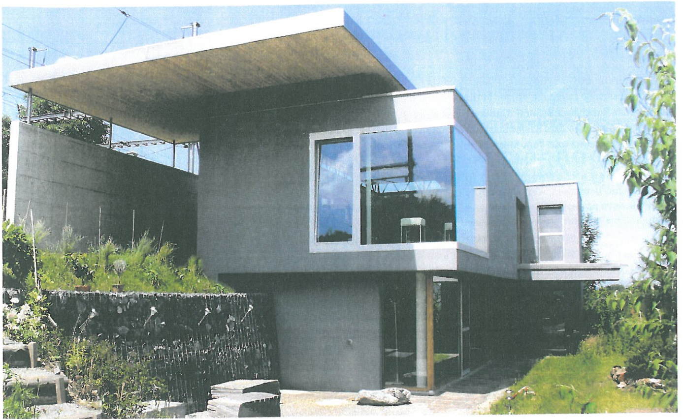
Eine Betonscheibe stemmt sich im Westen gegen den Hang und schützt vor Bahnlärm.
