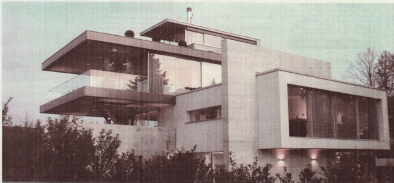
Zum See hin offen mit grosser Geste und viel Glas: Der dreigeschossige Wurf der Zürcher Architekten Arndt Geiger Herrmann in Pfäffikon SZ
