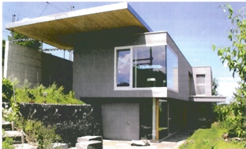
Eine Betonplatte stützt sich im Westen gegen den Hang und schützt vor Bahnlärm.
